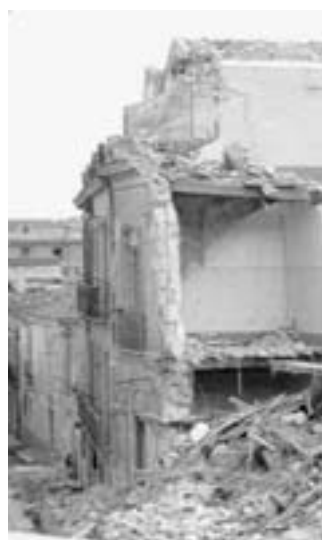
Cagliari: via Iglesias distrutta dalle bombe
